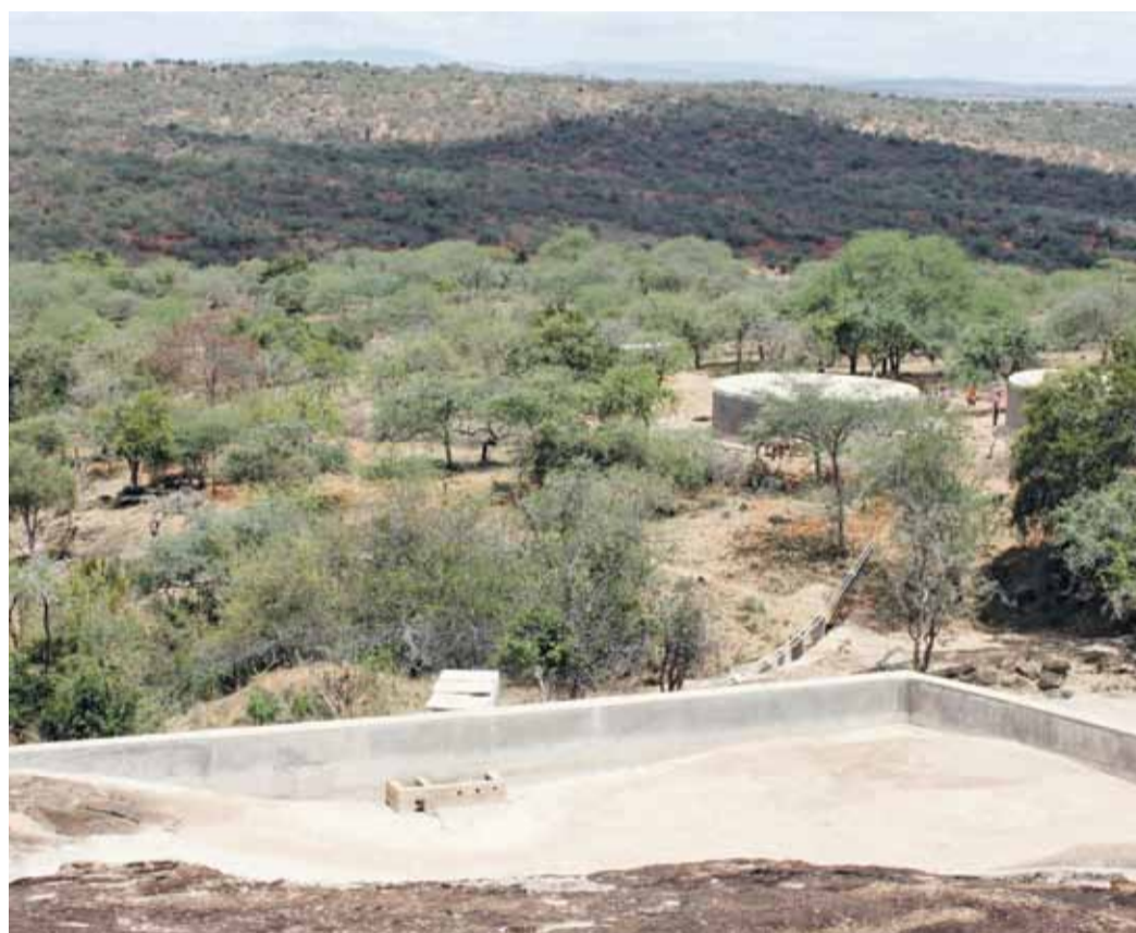
FELSREGENFANG: Ein kahler Felsen wurde eingefasst, das Regenwasser wird zu Tanks (im Hintergrund) weitergeleitet.
